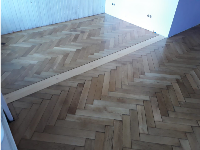
Zusätzlich wurde in der Wohnung 18/1 der Küchenboden aufbereitet
